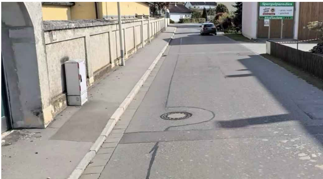
NUR EINSEITIGER GEHWEG AM CABRINI-ZENTRUM, FEHLENDE ABSenkUNG NAHE HOFLADEN (-)
