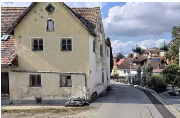
GEFÄHRLICHE KURVE, KEINE GEHWEGE (-)
