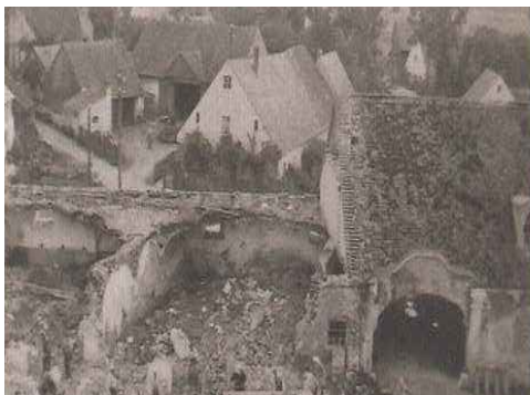
BAUSTELLE VON OBEN
