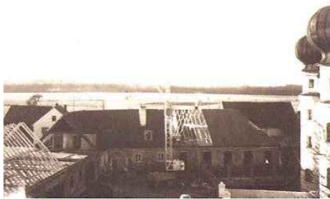
DACHSTUHL VOR DER FERTIGSTELLUNG
