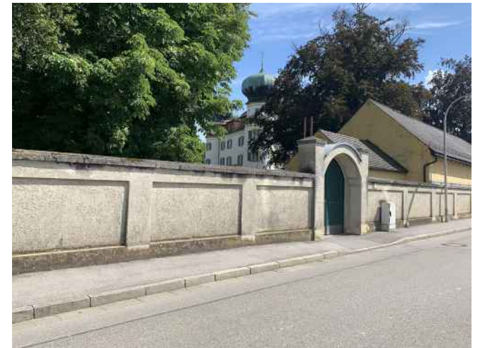
UMGEBENDE MAUER NACH SCHLOSSUMBAU
