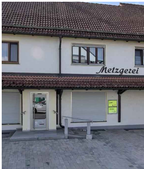
ZUGANG ZUR METZGEREI ÜBER RAMPE MÖGLICH (+)
